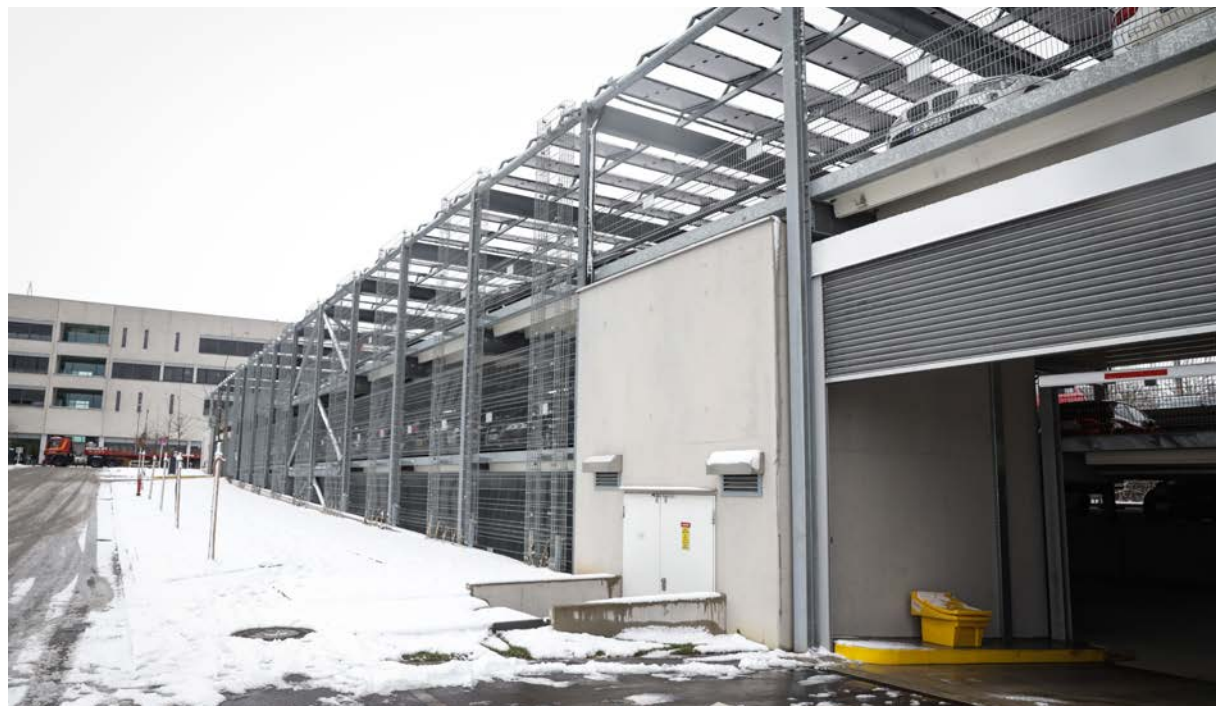
Das Parkhaus des „House of Biohealth“ mit dem neuen „Stockwerk“
